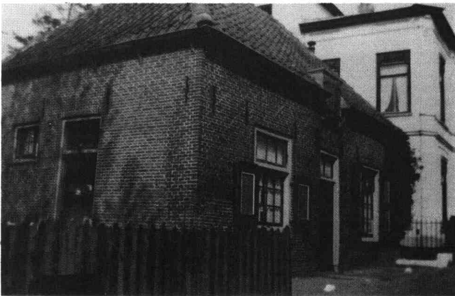
Het huis van Willem Gerssen. Het is als koetshuis gebouwd bij het herenhuis in 1871. Nadien maakte het diverse verbouwingen door. Op de foto is de plaats nog te zien van de grote deuren in de westgevel; daar werd later een kleinere deur met bovenlicht ingezet. Het raampje ernaast is van een opkamertje.
