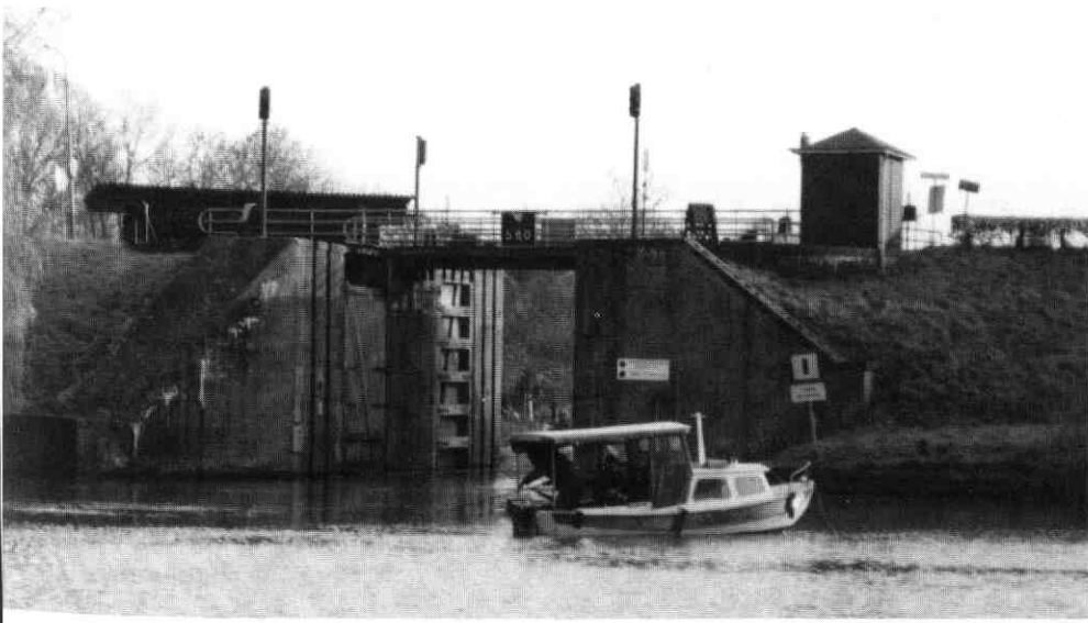
afb. 3 Eén van de waaier- sluizen bij Asperen. De opening wordt afgeslo- ten met één enkele wai- erdeur, links op de foto van de auteur.
