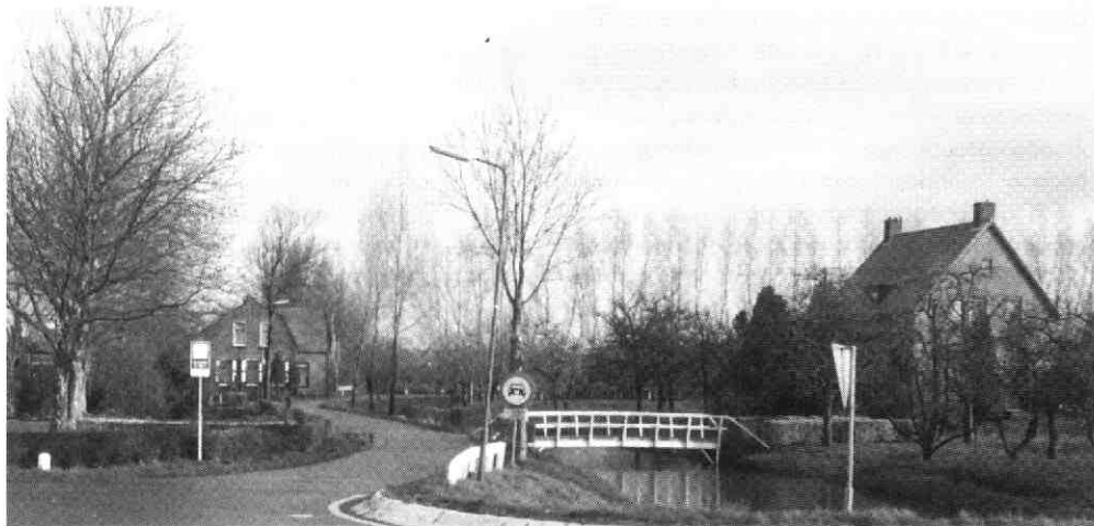
afb. 18 Huidige situatie van het 'Hemeltje'. Linksonder lag de voormalige 'Endelbrug'. De waterverbinding geschiedt nu met 'duikers'.
