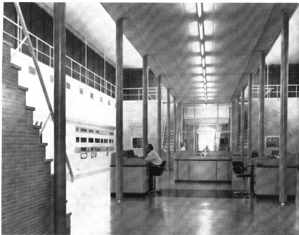
9. De zender-ruimte met op de stalen kolommen de uitgespaarde lichtstraat en rondom achter de stalen railingen ruimten voor de kabels.
