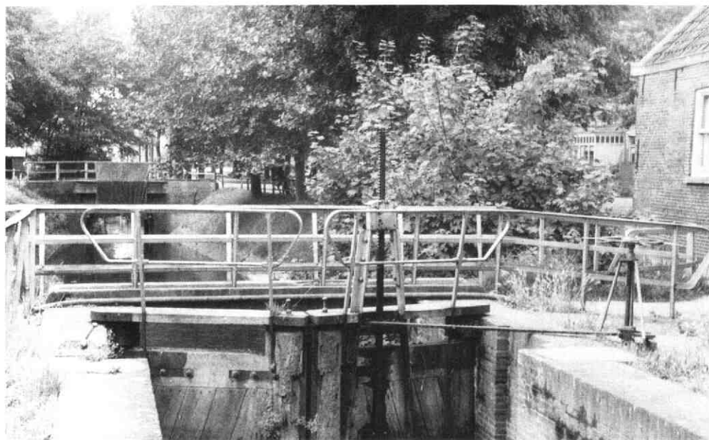
afb. 16 Situatie van de sluis in 1960 gezien in de richting naar de Karnemelkse brug. Op de voorgond de noordelijke sluisdeuren. (foto L. Murk)
