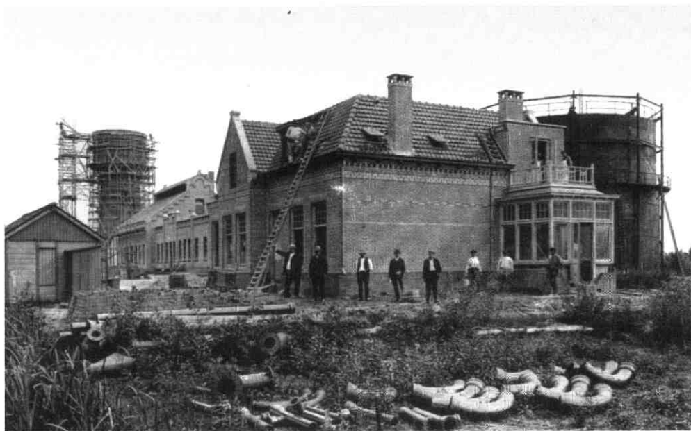
Bouw van de gasfabriek in 1911.
