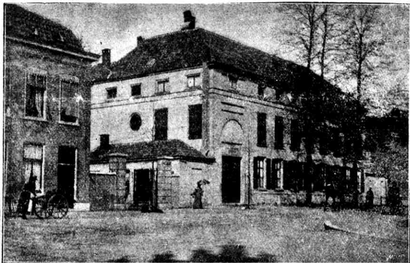
Het Hoofdgebouw aan de Biltstraat.
