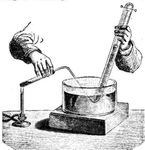
Fig. 48. De eudiometer wordt van zuurstof voorzien.
