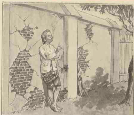
2. De man leunt tegen de muur.
