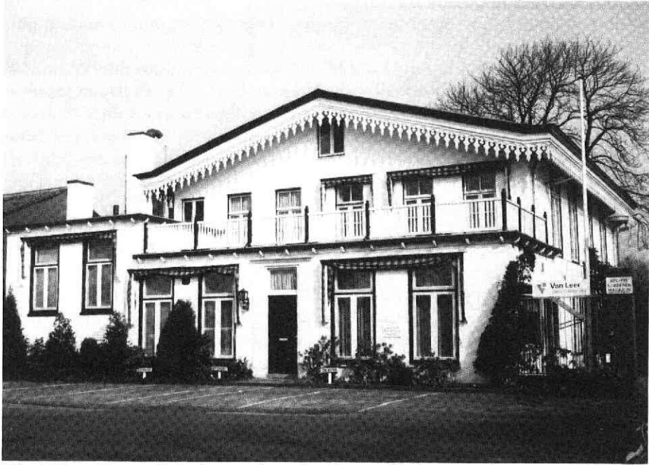
Afb. 1. Brugzicht met links de aangebouwde opkamer. Nu kantoorgebouw van de Vatenfabriek Van Leer. Maart 1993 (Foto J. Boerstra).
