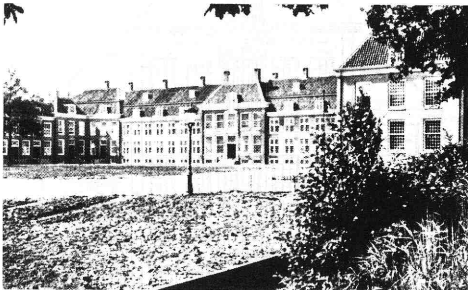
Het gerestaureerde Broederhuis
