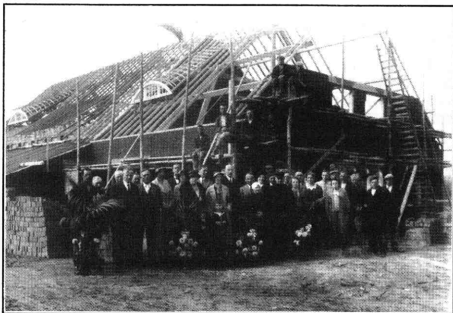
Bouw van de boerderij Nieuw Griffestein aan de Weteringlaan, 1933 (particuliere collectie)
