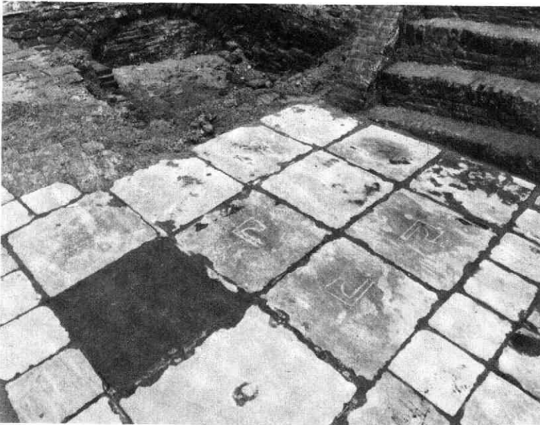
Afb. 79 Korte Smeestraat 2-6. Hardstenen „plavuizen“ met ingehakte timmermansbijlen in de kelder van Korte Smeestraat 2-4. Links een dichtgezette doorgang naar de kelder van Oude Gracht 302, die op een oorspronkelijk lager vloerniveau duidt.
