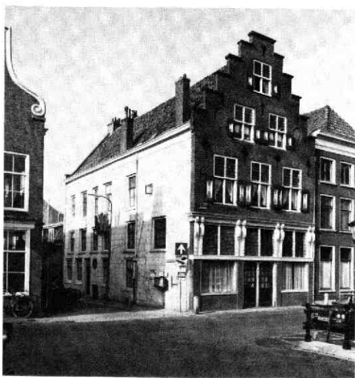
Afb. 90 Oude Gracht 319-321. Het huis met de in 1936 gerestaureerde 17e-eeuwse voorgevel gezien vanuit het zuidoosten.
