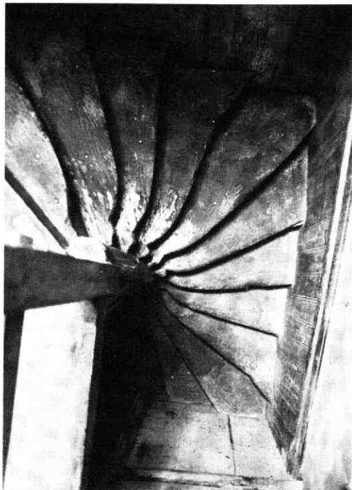
Afb. 66 Jansveld 4-20. De 17e-eeuwse spiltrap van Jansveld 10. Foto B. J. M. Klück.
