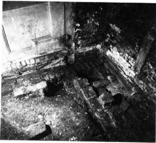
Afb. 17 Abraham Dolesteeg 11-17. Gedeelte van een middeleeuwse drempel en de rest van een steunbeer onder de ingang van 15. Rechtsvóór: de fundering van de 17e-eeuwse scheidingmuur.
