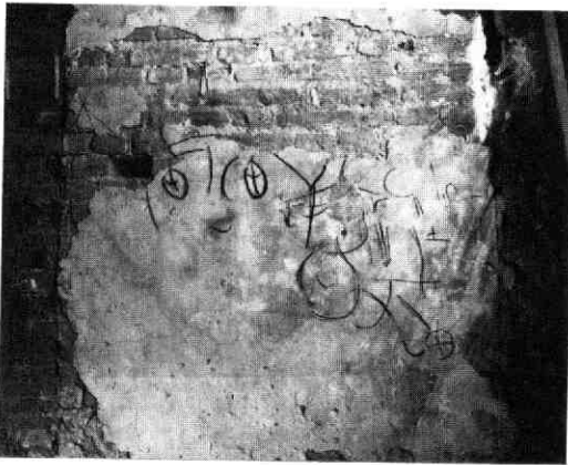
Afb. 55 Ganzenmarkt 2-8. Een van de beide muurtekeningen op de oostmuur van de tweede verdieping van Ganzenmarkt 8. Links: het schoorsteenkanaal.
