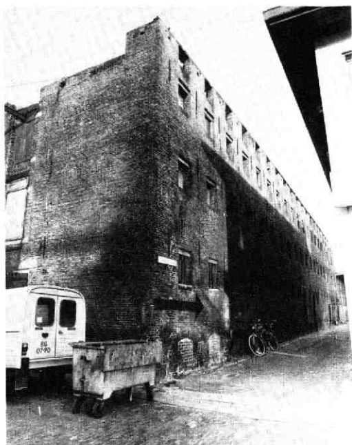
Afb. 96 Oudenoord 7. Voorgevel en zuidoostelijke zijgevel van het pakhuis aan de Raamstraat (1983). De kap is verwijderd.
