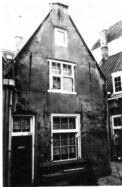
Afb. 62 Jansveld 4-20. De voorgevel van Jansveld 16. Foto B. J. M. Klück. Het vensterkozijn op de begane grond is een vermaakt kruiskozijn. Rechts is de ingang van 8 met zijn oorspronkelijke korbboognis zichtbaar.
