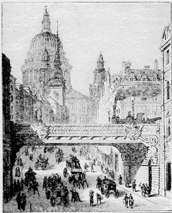
Eene straat met spoorwegviaduct in Londen. Op den achtergrond de Paulskerk.
