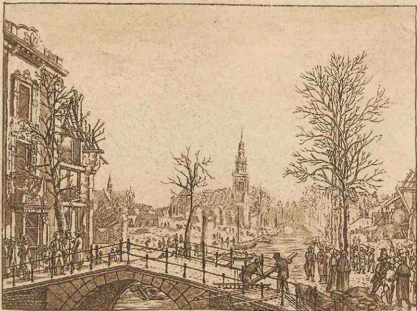
Ruines d'une partie du Repenbouwy à Leyde, à la suite de l'explosion du bûcher à poudre, au 22, Jan. 1672. à Amsterdam chez E. Maaskamp près du Palais.
