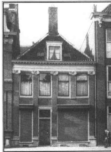
De voorgevel van Janskerkhof 11 tijdens de verbouwing (1922) en als Maison IPA in 1944 Foto's: Collectie beeldmateriaal HUA
