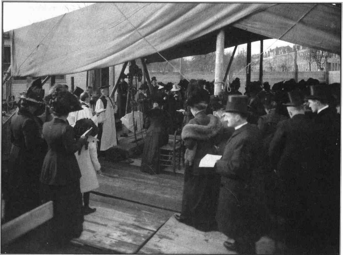
Eerste steenlegging van de Engelse Kerk aan het Van Limburg Stirumplein, november 1911
