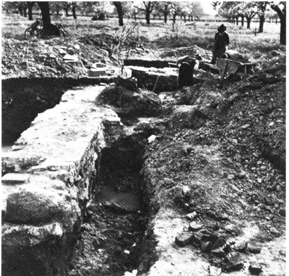
7. De Meern 1940. De fundering in proefput b, van noord naar zuid. In het midden en aan het eind (waar wordt gegraven) de beide zijmuren van het uitspringende vertrek aan de westzijde van de hoofdmuur. Foto E. M. Fraenkel-Nieuwstraten.
