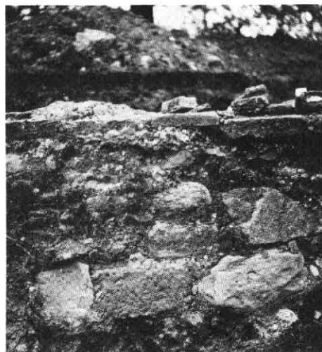
9. De Meern 1940. Zijkant van de fundering in proefput b. Foto E. M. Fraenkel-Nieuwstraten.
