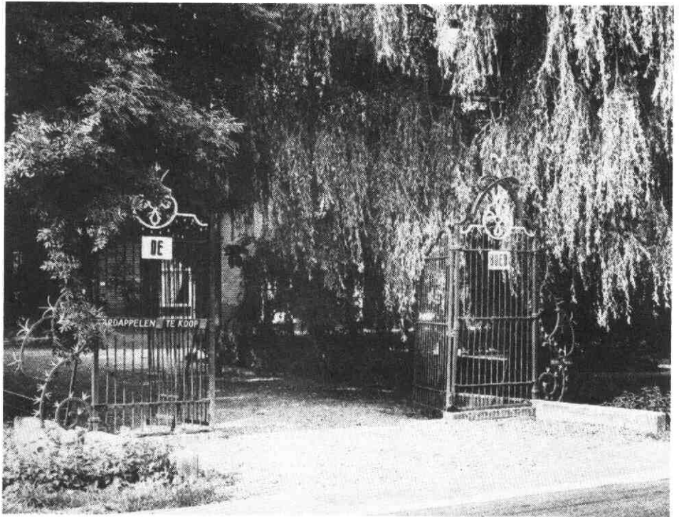
18de eeuws smeedijzeren hek van De Hoed, Utrechtseweg 111 te Vleuten. Het hek is momenteel in deplorabele toestand, maar er is goede hoop dat het, door samenwerking van eigenaar en Monumentencommissie, spoedig hersteld zal kunnen worden. Links van de boerderij ligt een eilandje dat een archeologisch monument is: terrein waarin aanleg en overblijfselen van het voormalige middeleeuwse versterkte huis Den Hoed. Hek en eilandje zijn Rijksmonumenten. Foto: F. C. J. van Baaren, 1975.
