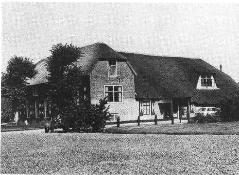
De Koningshof, Eikstraat 5 te Haarzuilens. Dwarshuis-boerderij uit de 17de eeuw, blijkens delen van het muurwerk mogelijk nog uit de 16de eeuw. Dwarss woongedeelte met rechts de opkamer, onder rietendak, rechts afgewolfd. Vensters met 6-ruits schuiframen en luiken. Goed bewaarde stal, haaks op het woonhuis. Rijksmonument. Foto: F. C. J. van Baaren, 1975.
