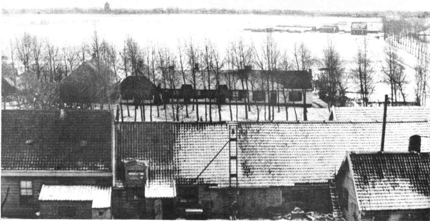
Foto uit het noorden (vanaf het kasteel in aanbouw). Op de voorgrond staan loodsen en werkplaatsen, opgetrokken ten behoeve van het grote werk. Zij stonden er dus oorspronkelijk niet en werden ook later weer afgebroken. Daarboven weer de zuidelijke bebouwing van de brink. Het met bomen omzoomde weggetje rechts op de foto is de oude Haarlaan. Links daarvan de steenbakkerij, die ten behoeve van de kasteelbouw ter plaatse werd opgericht. Links op de achtergrond de Hamtoren.
