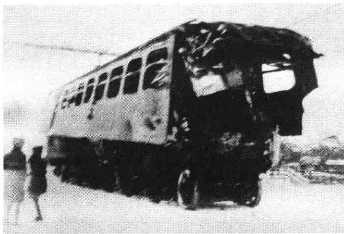
Het achterste rijtuig werd door de binnenrijdende locomotief geheel opgetild. Rechts-onder zien we de loopwielen van de loc.
