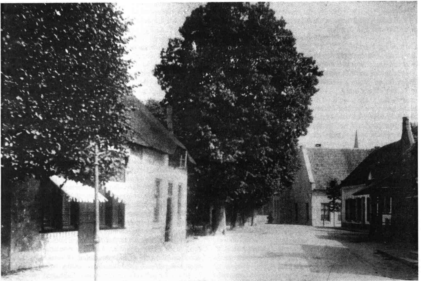
Foto vanuit het noordwesten. Links de Broederschapshuisjes, recht vooruit de Brouwerij en rechts respectievelijk de boerderij van de weduwe Van Dijk, de woning „bewoond door twee arme gezinnen” (met tuitgevel) en de smederij (met travaille). Foto van omstreeks 1895, eigendom van J.W. Schoonderwoerd te De Meern.
