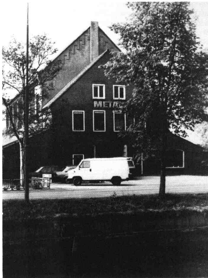
4. Het huidige aanzicht van de voormalige R.K. kerk aan de Rijksstraatweg vanuit het noordoosten
