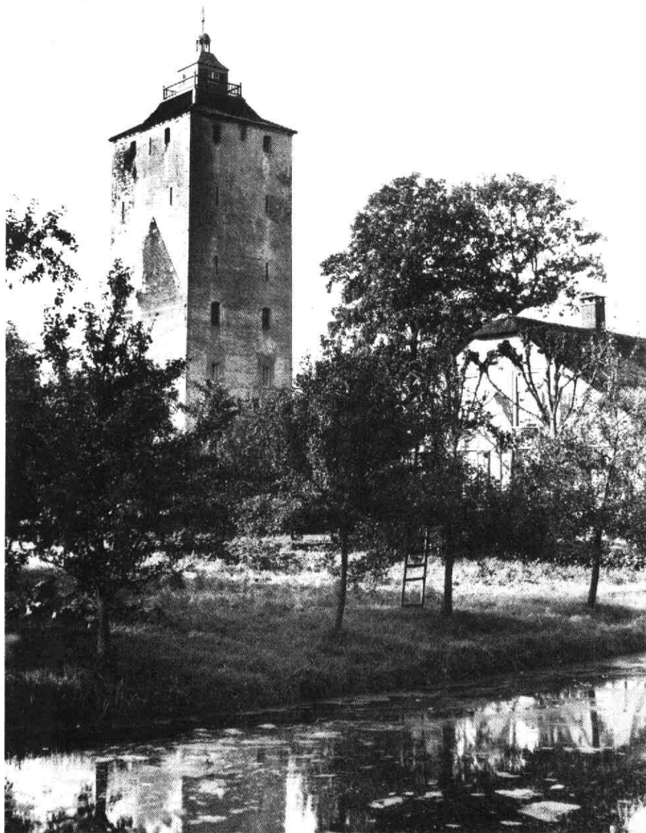
6. De Hamtoren na de restauratie. Het dak is vernieuwd en er is weer een balustrade. De schietgaten zijn in ere hersteld. De foto is gemaakt voordat in 1957 de ruilverkaveling begon: rechts is de voormalige boerderij van de heer Van Selm te zien en op de voorgrond de thans gedempte Vleutense Wetering.
