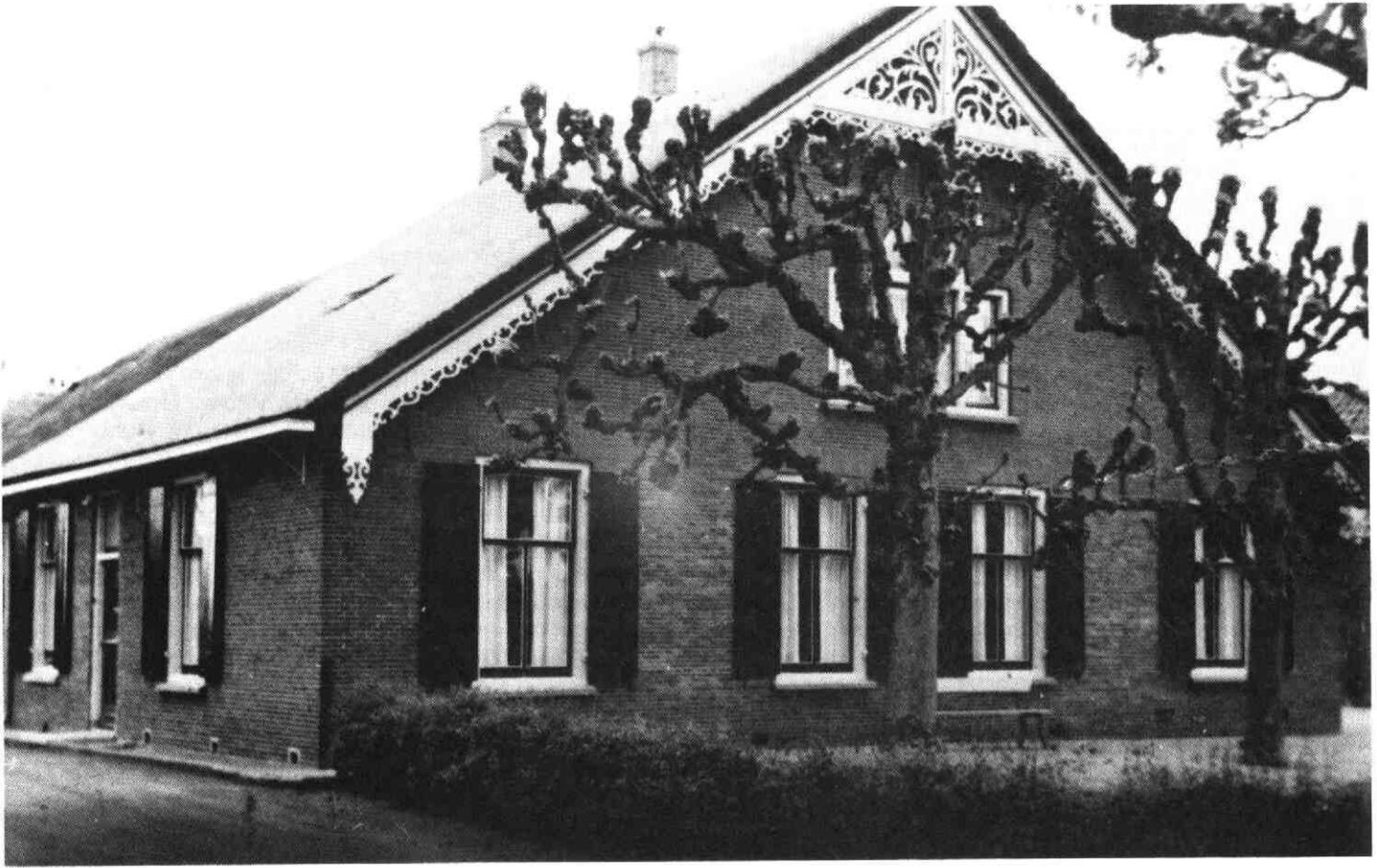
Afb. 2 Zeldenrijk in 1936. De foto is ter beschikking gesteld door mevr. van Rooijen-Kromwijk. Volgens beschrijving van O. Wttewaal en D. Cramers in 1988 is het een langhuisboerderij gebouwd omstreeks 1860 en heeft het een rieten zadeldak, een gesneden windveer en topgevelveld met levensmotief. Ligging: 't Hoog 6 4).
