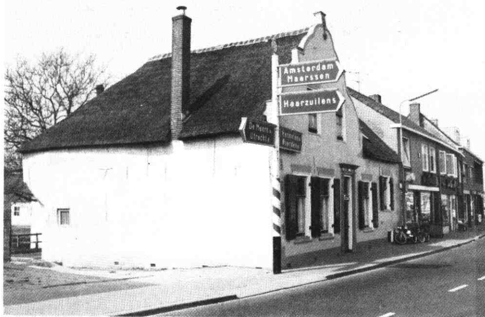
Afb. 6 Foto van het huis Dorpsstraat 8 in 1971. Aan de achterkant van de zijgevel, waar de steeg was, is de afgeschuinde hoek van de gevel te zien. Het huis aan de oostzijde van de steeg was toen al afgebroken. (foto J. Verheul, arch. fam. Van Dijk)
