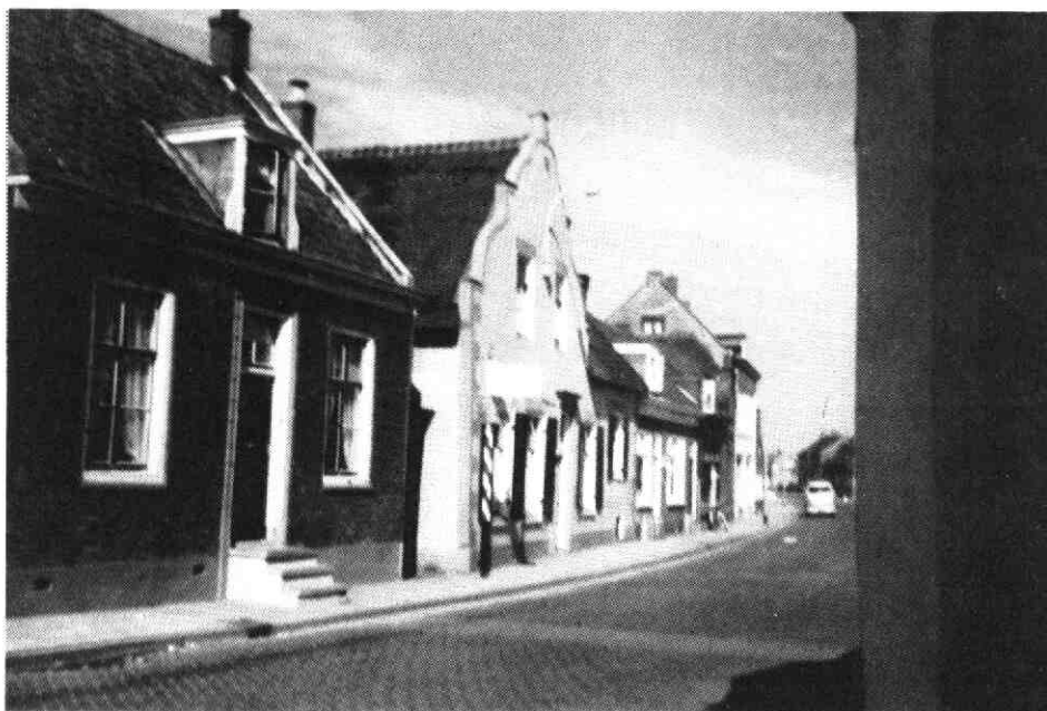
Afb. 5 Foto van de zuidzijde van de Dorpsstraat rond 1955. Helemaal links het huis dat oostelijk van de steeg stond, rechts van de steeg het huis van de familie van Dijk. (arch. fam. Van Dijk)
