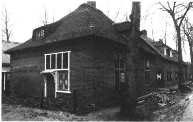
afb. 6. Eikstraat no's 2 -12 tijdens de renovatie in 1994
