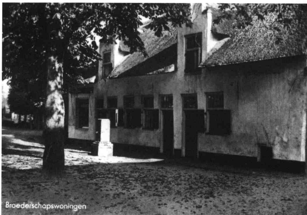
Afb.5. Foto van de broederschapshuisjes rond 1940. Hier is de 2e deur van links verdwenen en het meest linkse raam vervangen door een groter (winkel)raam. De oude pomp is vervangen door een gemetseld bouwsel met een drinkwaterkraan.
