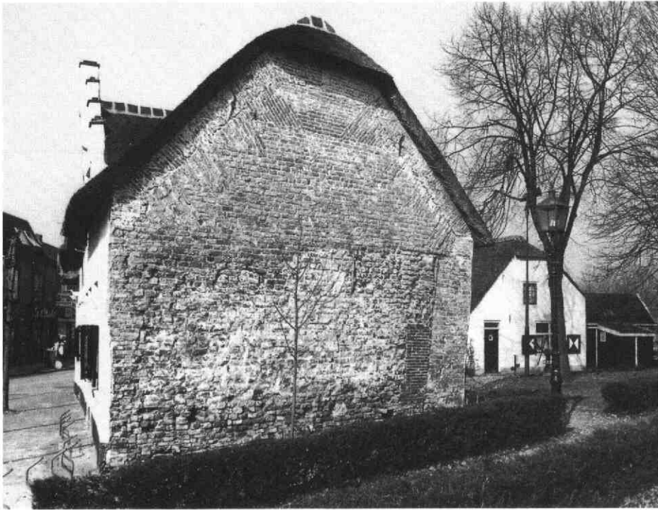
Afb.6. Foto van de oostgevel van de broederschapshuisjes toen in 1986 een nieuwe pleisterlaag werd aangebracht. In het oude metselwerk is te zien dat daarin in vroeger tijden nog een raam of deur heeft gezeten.
