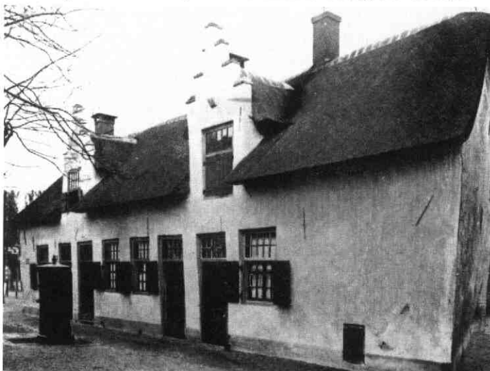
Afb.4. Foto van de broederschapshuisjes rond 1930. Hierop is de oorspronkelijk indeling van ramen en deuren nog te zien, evenals het kelderluikje in de voorgevel en de pomp die voor de huisjes stond.
