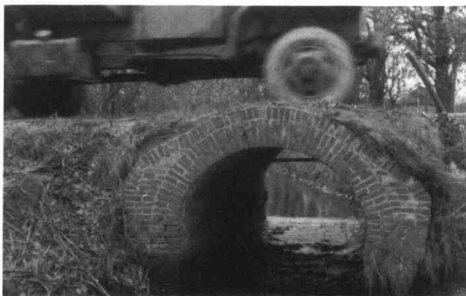
Gezicht vanuit het oosten op een gemetselde heulbrug in de Haar- of Rijndijk in Haarzuilens. Deze heulbrug vormde een verbinding tussen het westelijke en het oostelijke deel van de polder de Haar. Het kunstwerk is kort na de fotografische opname vervangen door een rechthoekige betonnen duiker onder het noordeinde van de Rijndijk.
