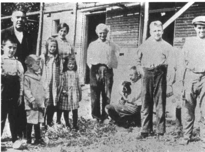
Familie Boeijen met personeel bij het huis van Cor van Eijk in aanbouw. Van links naar rechts: Piet Boeijen, Henk Boeijen, Nico Boeijen, Cor Boeijen, Anna Boeijen-van Rooijen, Jopie Boeijen, Dirk Barten, Frans Visee met hondje Polly, Cor van Eijk en Adriaan Links.
