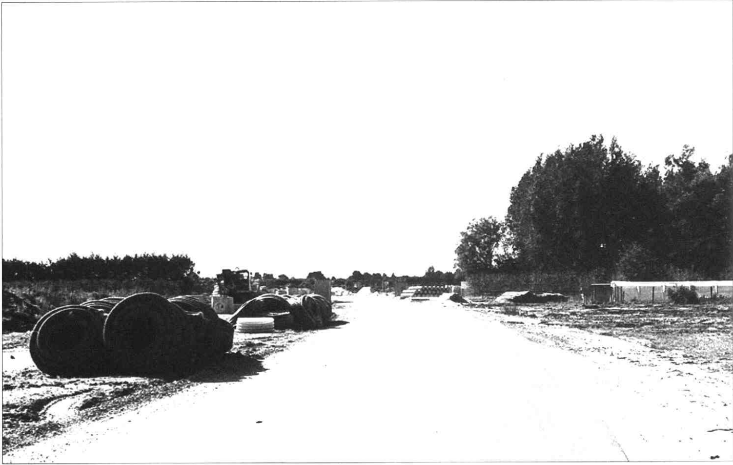
Zo lag de Langerakbaan erbij in september 1997. Alle materialen voor het bouwrijp maken liggen langs de bouwweg opgetast. Achter de hoge bomen rechts ligt het Klifrakplantsoen, met de eerste huizen van Leidsche Rijn.
