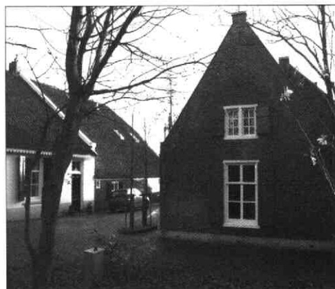
Rijksstraatweg 12 en 12b, Rhijnzicht met bijgebouwen, uit de 18e eeuw. Links van de foto zal in de nieuwe situatie de HOV-baan naar Hooggelegen voeren.
