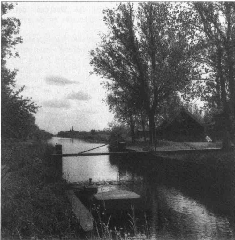
De voormalige Joostendammersluis met draaiplank tussen de Bijleveld en de Heycop ten noorden van Kockengen. Gezicht vanuit het noorden. Op de achtergrond de Heycop met in de verte het dorp Kockengen. De Joostendam werd in 1658 veranderd in een schutsluis met waarschijnlijk een draaiplank voor voetgangers die het zandpad langs de Bijleveld naar Oudhuizen gebruikten. De sluis werd in 1967 opgeruimd. Foto auteur 1958.
