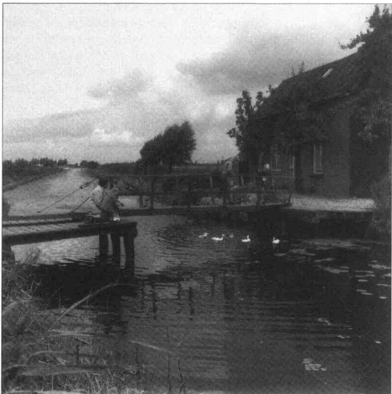
Draaiplank over de Bijleveld ten westen van de voormalige Haarkorenmolen. Gezicht vanuit het zuidoosten. Deze draaiplank met leuningen kwam in 1912 in de plaats van de kwakel uit 1621 (zie de afbeelding daarvan uit 1761). Van het contragewicht van de draaiplank is links nog een gedeelte zichtbaar. Deze draaiplank kwam in 1960 te vervallen, toen de Bijleveld werd gedempt. Foto auteur 1958. Hierop afgebeeld v.l.n.r. mevrouw Storm van Leeuwen met 3 van de 5 kinderen, Margo, Ewout en Frans. (red.)
