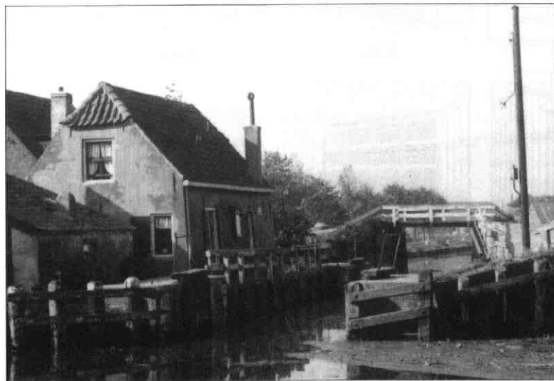
De sluis aan de Stadsdam.
