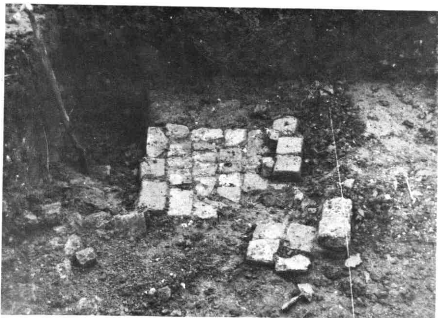
De steunbeer met een deel van de puinbaan en van de fundering.
