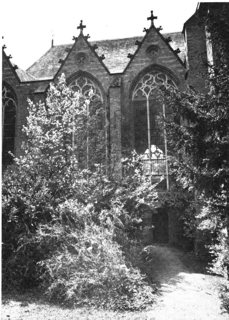
De toegang naar het 'noormannendeurtje', waarover vele verhalen de ronde doen. Het lage deurtje bevindt zich in de noord-westgevel van de kerk.
