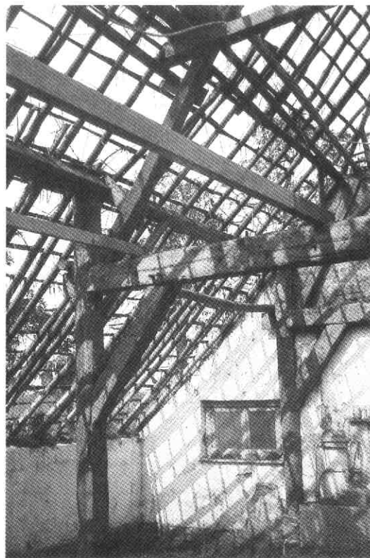
De nieuwe kapconstructie.
