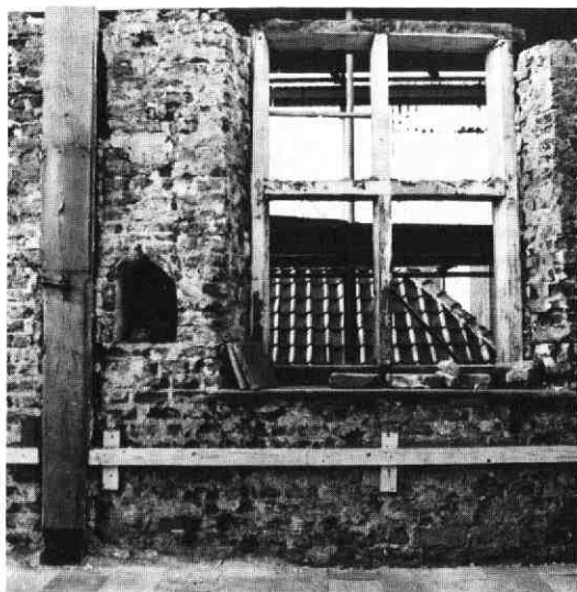
Afb. 17. Muurstijl met geopende en gesloten kaarsenis, noordwestwand dormatorium (foto Paul van Vliet, 1983).
