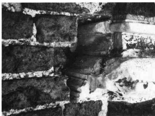
Een uitgehakt kapiteel op de vierde geleding van de toren. Let op de oorspronkelijke profilering welke in de muur tevoorschijn is gekomen.
