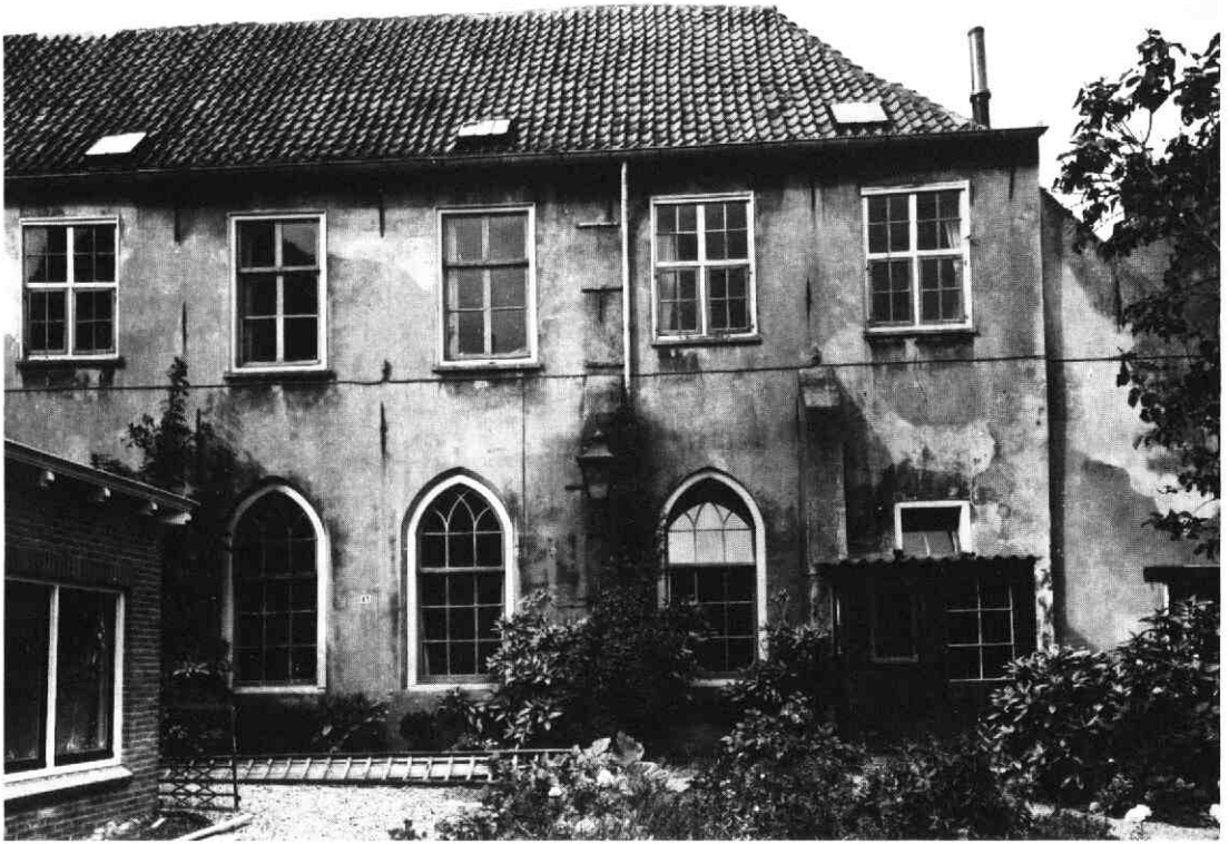
Afb. 20. Zuidoostgevel vóór de restauratie (foto Rijksdienst voor de Monumentenzorg, 1958).
