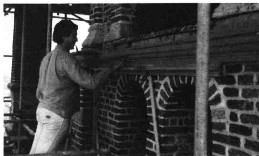
Tijdens het herstellen van de waterlijst op de vierde geleding.
