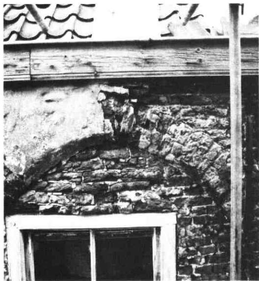
Afb. 22. Bovengedeelte z.w. gevel na ontpleistering (foto Paul van Vliet, 1983).
