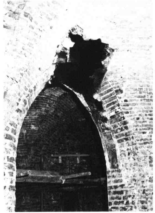
Afb. 11. Rookkanaal ter plaatse van ingang kapittelzaal vóór de restauratie en tijdens de restauratie, de ingang is weer open (foto's Paul van Vliet, 1970 en 1984).
