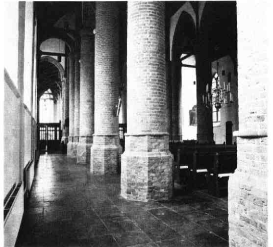
De noordelijke omgang van het schip in de richting van het koor, situatie van 1983.
