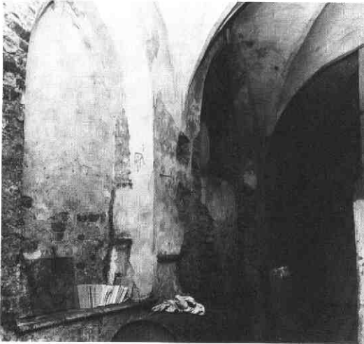
Afb. 5. 'Kloostergang' vóór restauratie (foto Paul van Vliet, 1970).
