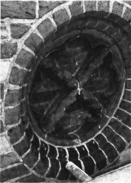
Een gaaf radvenster met blindtracering in de topgevel van het koor.
