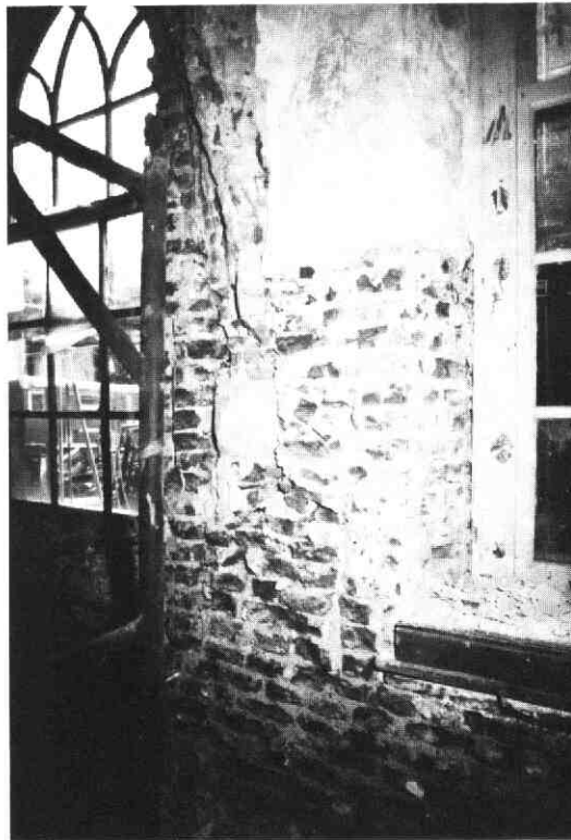
Afb. 9. Oversnijding van kraagsteen en gewelfaanzet over dichtgemetselde nis (foto Paul van Vliet, 1983).
