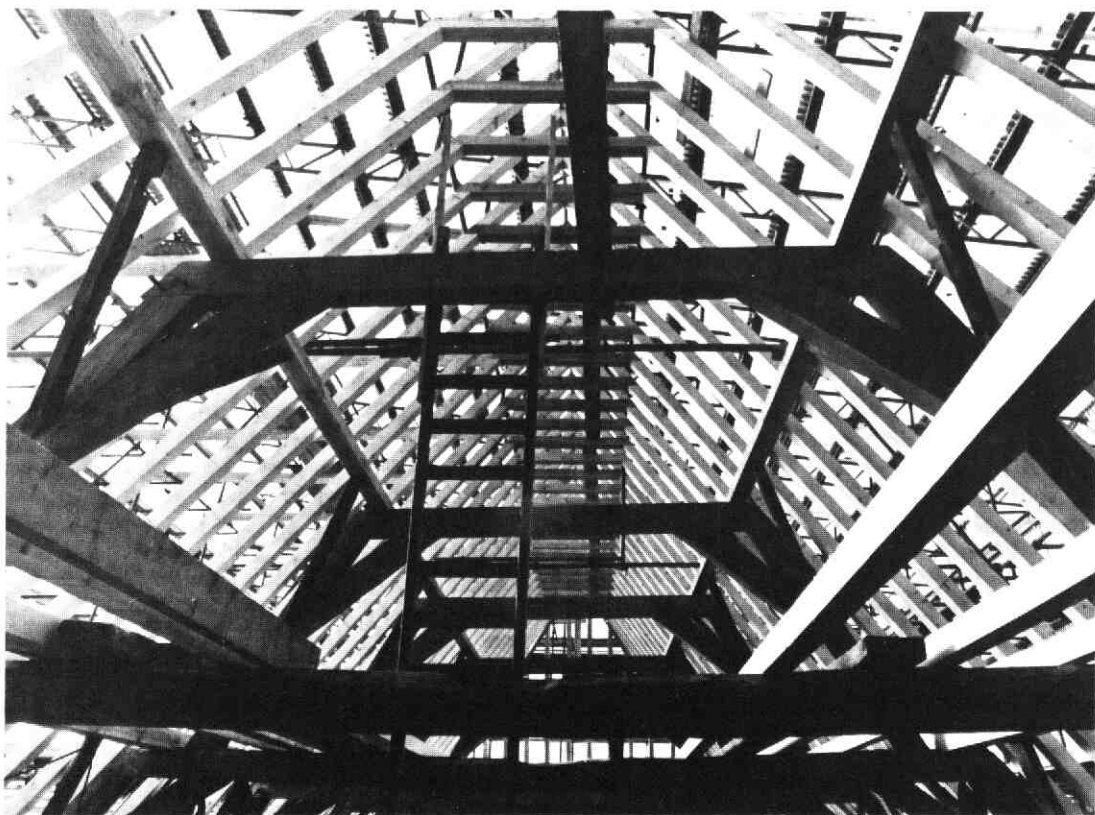
Afb. 19. Kapconstructie thans: doorgaande dakvlakken en een centrale nok. Op de grotendeels bewaard gebleven oude brede jukken (onderin) is een tweede reeks jukken geplaatst, die daar tot 1736 ook zijn geweest (foto Paul van Vliet, 1984).
