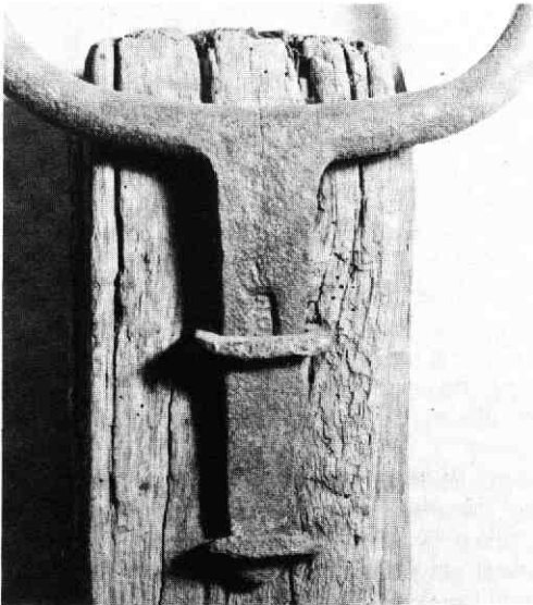
Een schilijzer wordt met krammen aan de paal bevestigd. Ook het maken van krammen was het werk van de smid. Zie de initialen van de maker van het ijzer: het smidsteken.
