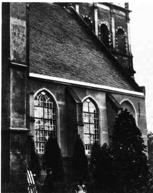
De noordgevel richting toren vóór 1911. De muur is bepleisterd en de raamconstructies zijn van hout.
