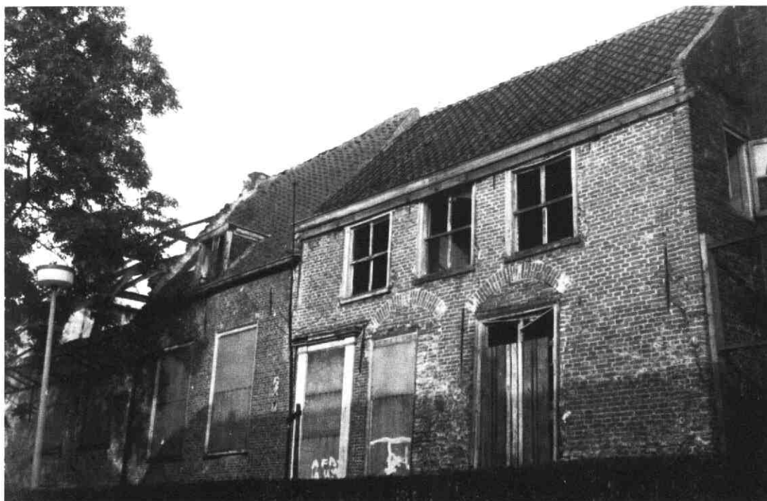
Havenstraat 6 en 7 in 1979, dit zijn 2 van de oudste panden in IJsselstein.
