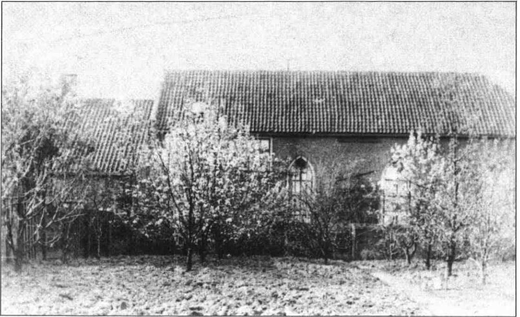
De schuilkerk aan de Havenstraat gezien vanaf de Walkade. Na 1888 is dit gebouw ingericht als gereformeerde kerk.
