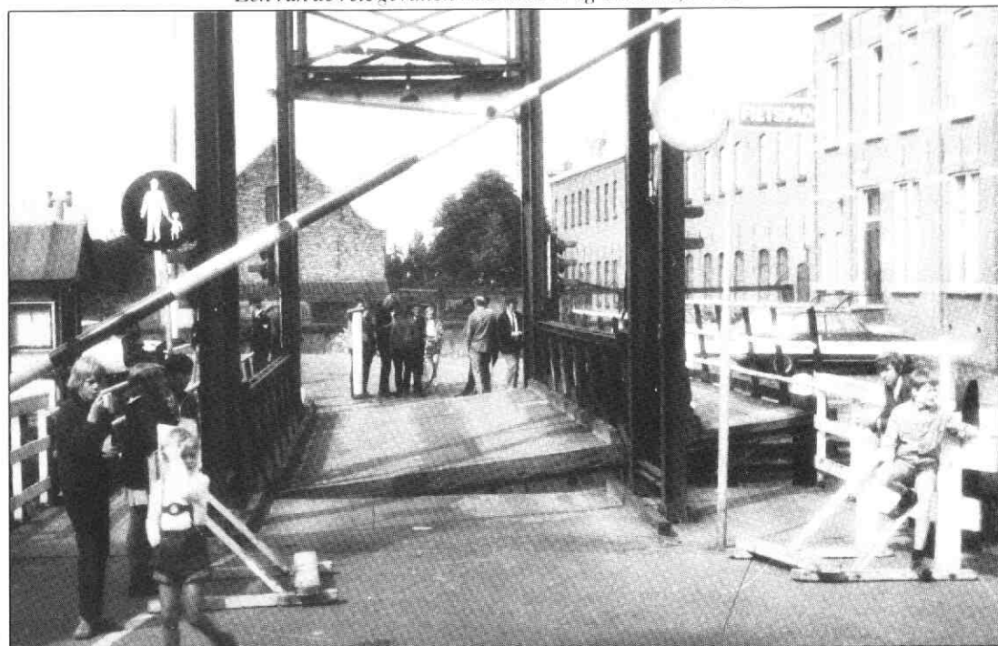
Eén van de vele gevallen waarin de brug ontzet is, 1971.
