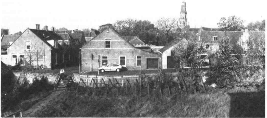
Afb. 1. Huidige situatie aan de zuidoostzijde van de binnenstad. De muur is gestut met houten balken. Op de achtergrond de oude Nicolaaskerk. (foto: Bram van Mens)
