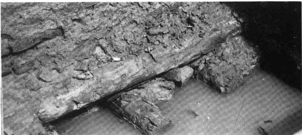
Afb. 7. Eikehouten balken dragen de fundering van deze stadsmuur.
