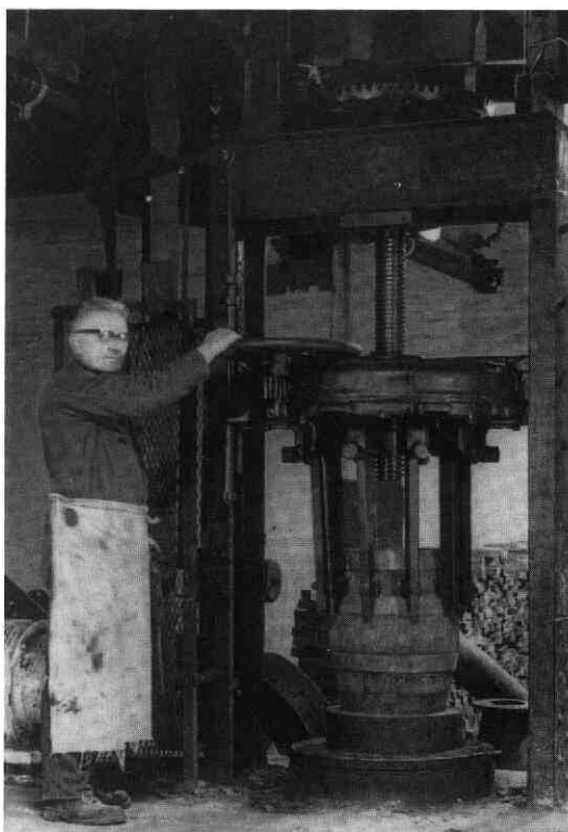
33. Rechts perst kuiper Verloop de banden mechanisch om een biervat en links doet kuiper Meester dit op traditionele wijze met kuipershamer en slagijzer.
