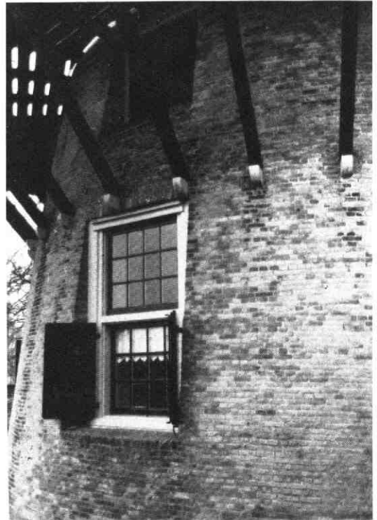
Raampartij met de ingemetselde hardstenen neuten.
