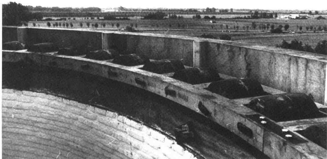
Rolring op de kruivloer, voor plaatsing van de kap.
