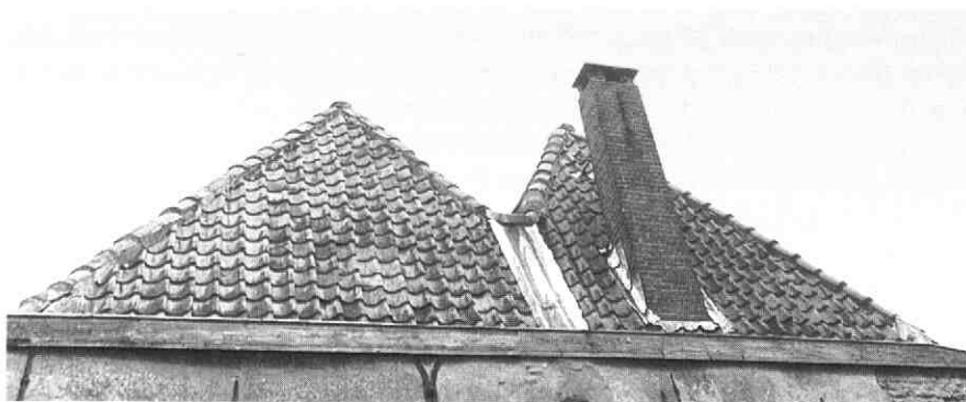
15. Hiernaast: In 1736 werd de grote kap vervangen door 2 kleine kappen met een 'zakgoot'. Bij de restauratie in 1984 is weer teruggegrepen naar de oude situatie; zie restauratietekening hierboven.
