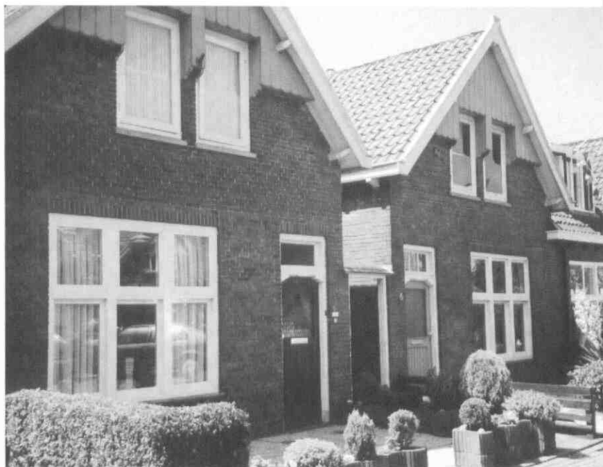
Situatie in 2000. De structuur van de huisjes en het plein is bewaard gebleven evenals verscheidene 'orginele details'.
