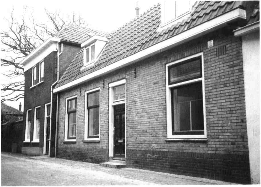
Kapellestraat 2 na de verbouwing.
