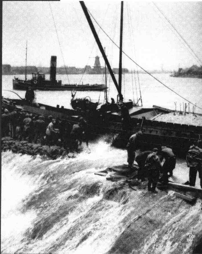
Wij kregen de taak om de met zand gevulde zakken en betonblokken in het gat te dumpen. (rechts op de foto)
