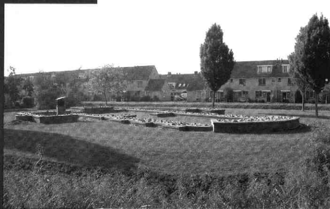
7. Opgemetselde funderingen van de kerk van Eiteren anno 2003 (foto: R. Ooyevaar).
