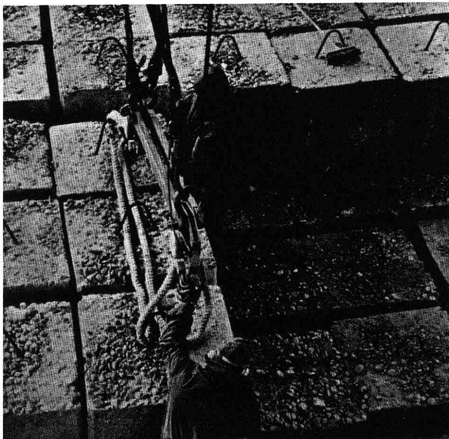
1 betonblok weegt 2,5 ton
