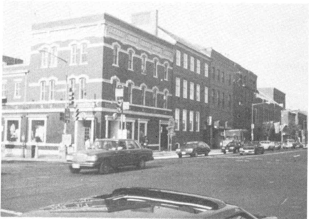
kruispunt Georgetown Marbery House ST. en de 31 ste St.
