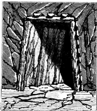
Met hout gesteunde gang in een steenkoolmijn.
