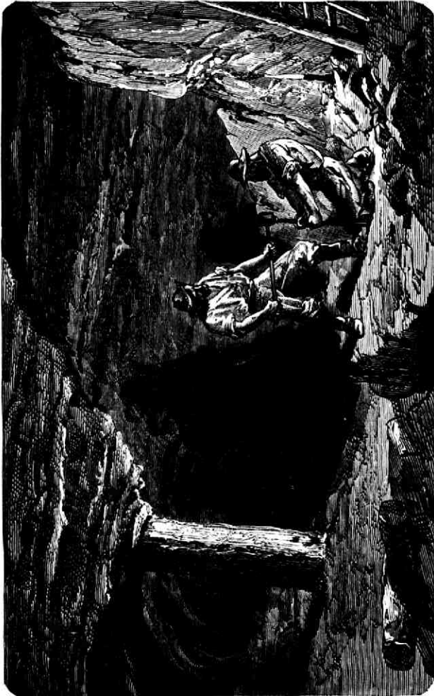
Het boren van een gat, in het gesteente
