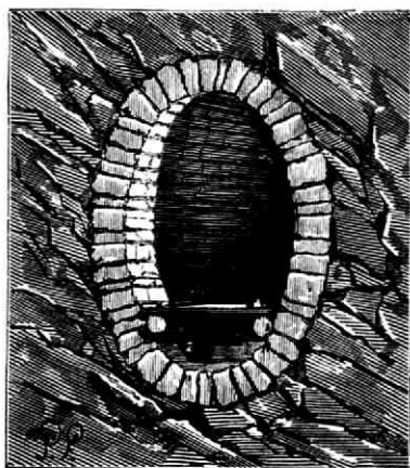
Gemetselde gang in een steenkoolmijn.
