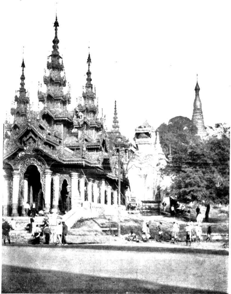
DE ZUIDELIJKE INGANG VAN DE SHWAY DAGON PAGODE.
