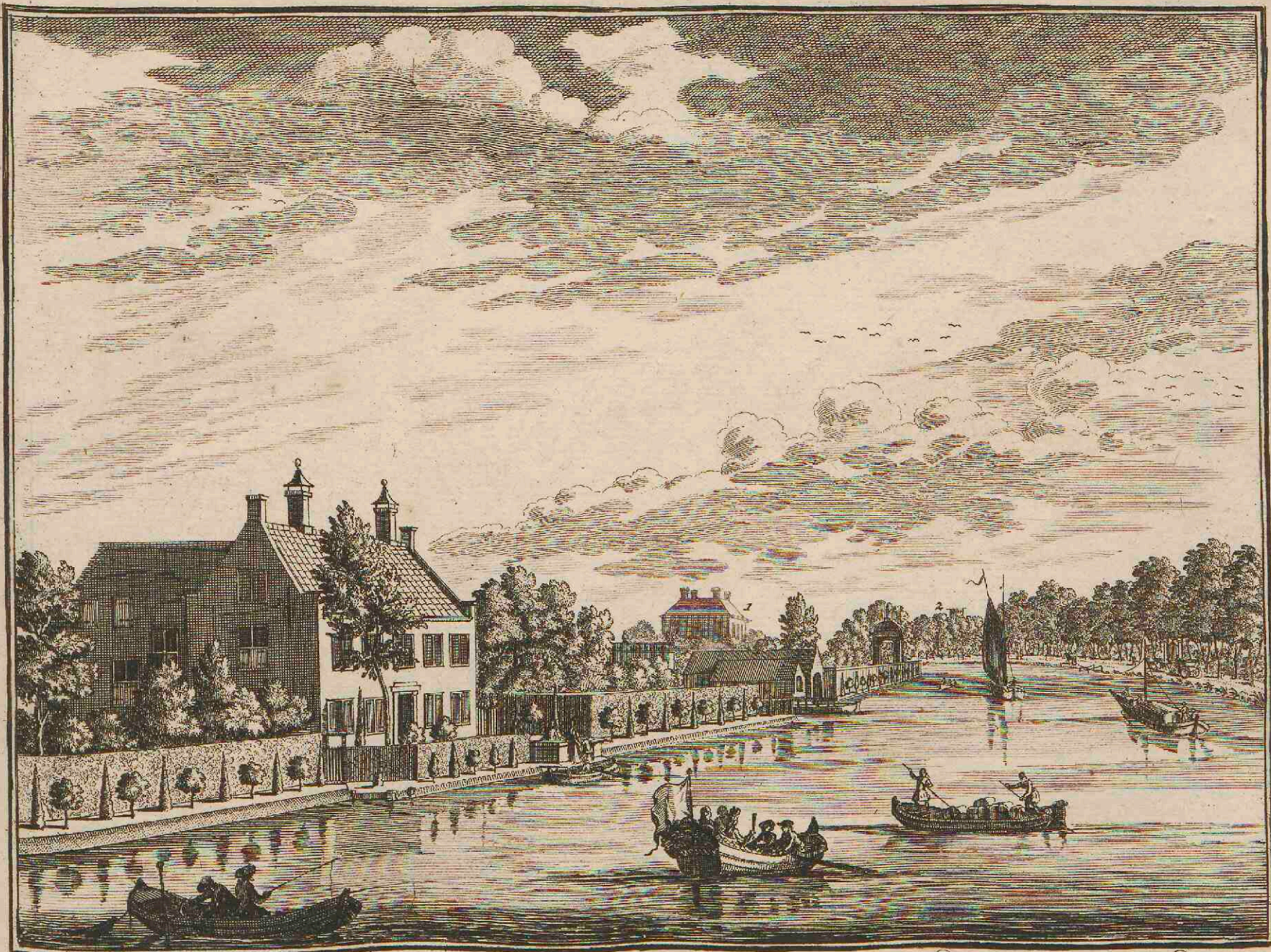
VREDENOORD; siende naer (1) de plaats van den H. o Boendermaker en op (2) Gunterstein.
