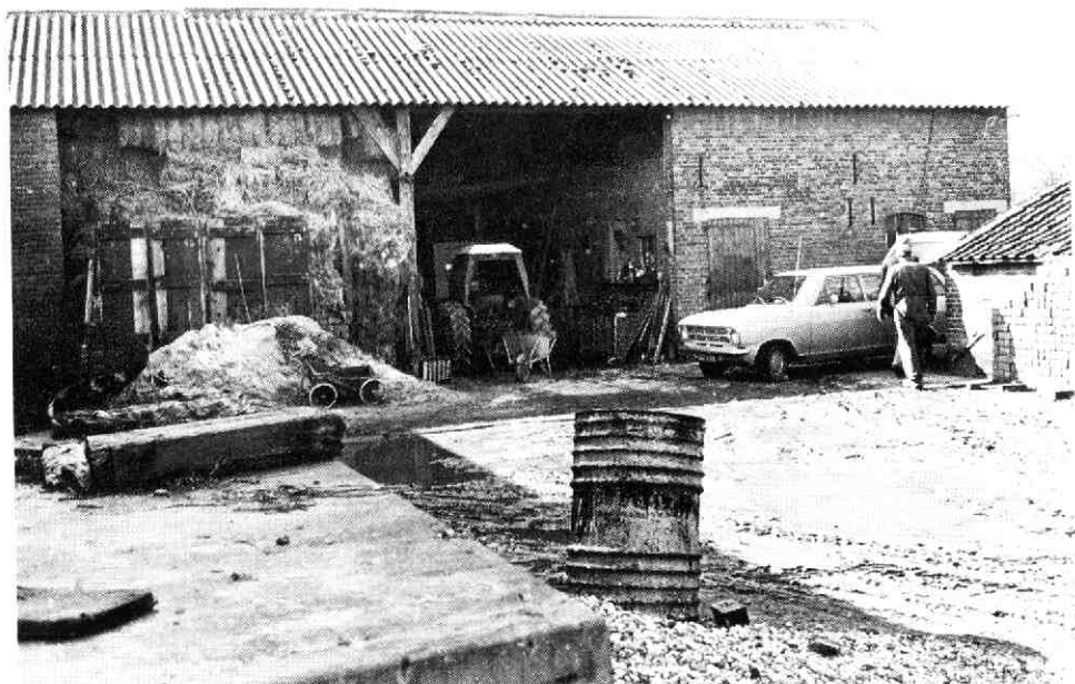
Fig. 2. Overzichtsfoto, genomen op de in de plattegrond met een x aangegeven plaats. Deze foto geeft een vooraanzicht van de loods.
