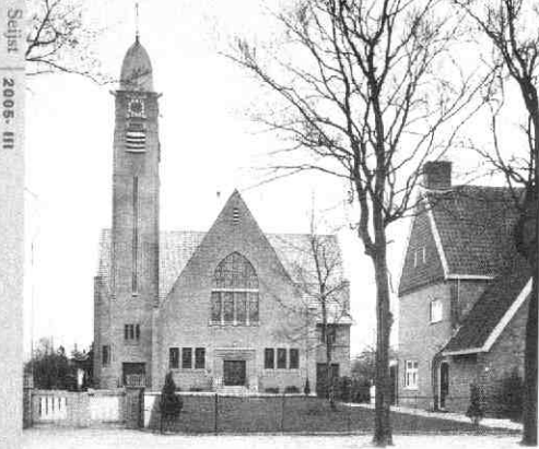
De Noorderkerk (later Bergwegkerk en nu Noorderlichtkerk genoemd) aan de Bergweg met rechts de pastorie, een beeld uit 1933.
