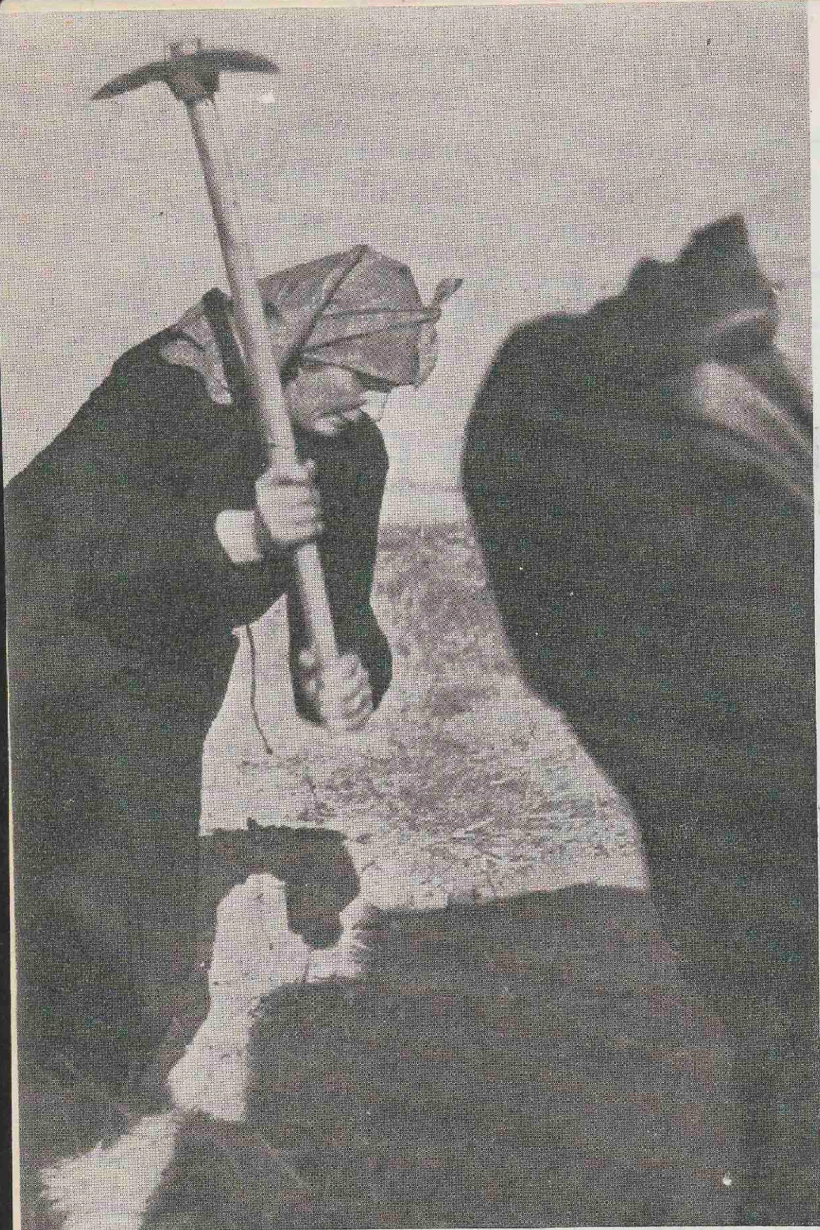
"Pasionaria", trabajando en la fortificación de Madrid.
