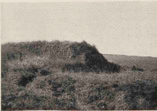
De oude zeedijk om de Zuid-Akkers te Buren. De buiten (zee)kant is steil.
