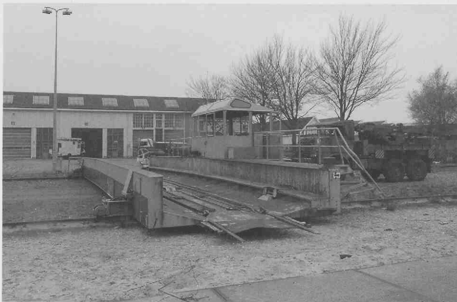
Wagenwerkplaats; rolbaan waarmee wagens konden worden verplaatst naar een ander werkplaatsspoor
