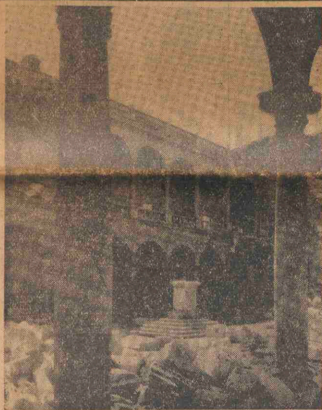
Patio en ruinas del Alcázar, una de cuyas columnas caídas se envía a la Argentina
