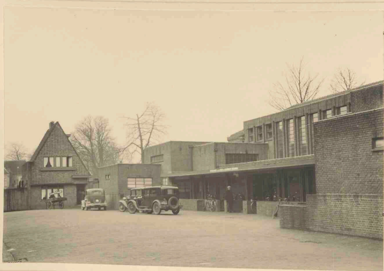
Polikliniekgebouw Vaartsche straat
