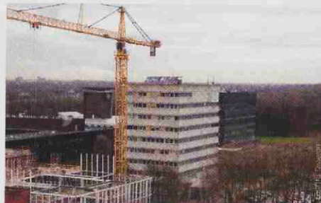
Op de achtergrond in donkergrijs het GML en op de voorgrond de bouw van het nieuwe onderwijscentrum voor Geo en Bèta
