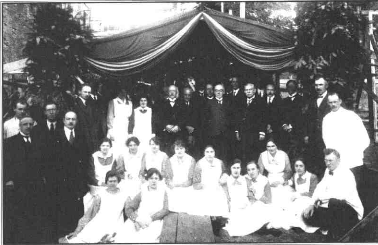
24 september eerste steenlegging van het nieuwe zusterhuis van het gesticht voor krankzinnigen Foto: Het Utrechts Archief
