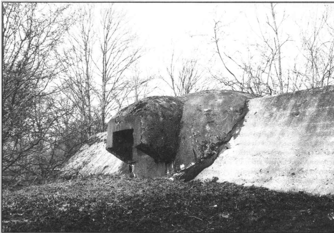
Mitrailleur- kazemat met gietstalen koepel op Fort bij Vechten Foto: D.C. Leegwater
