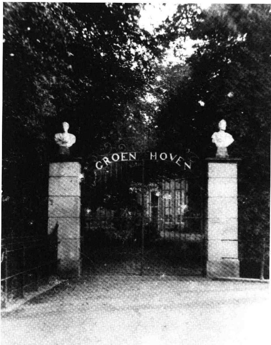
Het hek van Groenhoven te Oud Zuilen in 1895 met het vlak daarna afgebroken huis op de achtergrond. Dit hek wordt weer op de oude plaats aan de ingang van het nog bestaande wandelpark door onze stichting herbouwd (collectie Van Ommeren-Hoenson te Leersum).
