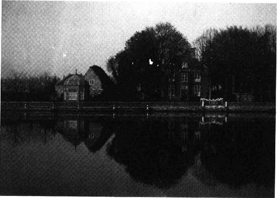
Afb. 10. Beek en Hoff met de lange stenen balustrade langs de Vecht, die de Zusters hebben laten afbreken wegens hoge onderhoudskosten (familiearchief Van Westrop).
